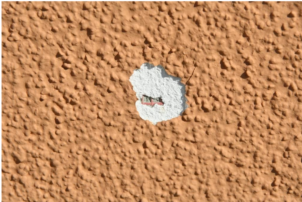
Foto 3 - Detail Putzschäden
